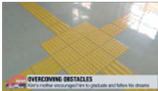
▲ 추가 설치된 점자 블럭
